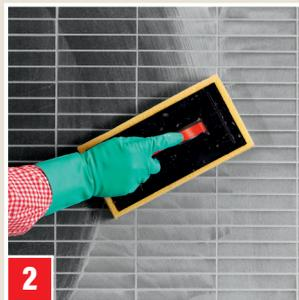
2 Mörtel ansteifen lassen. Der Zeitpunkt ist erreicht, wenn der Mörtel nicht an der Fingerkuppe haftet (abhängig von Baustellenbedingungen, Fugenbreite, Fliesenart). Dann die Fugenoberfläche mit leicht angefeuchtetem Schwamm eibnen ("bügeln").
