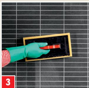
3 Mörtel erneut ansteifen, d.h. matt werden lassen. Mit Schwamm/Schwamm-brett reinigen. Schwamm/Schwamm-brett wiederholt in klarem Wasser reinigen und gut ausdrücken.
