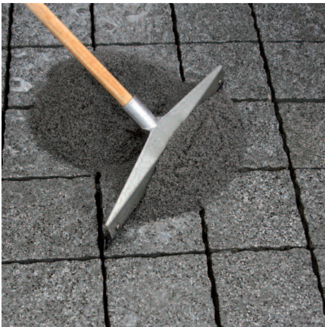
PCI Pavifix 1K Extra mit einem Gummischieber unter Druck in die Fugen einarbeiten.
