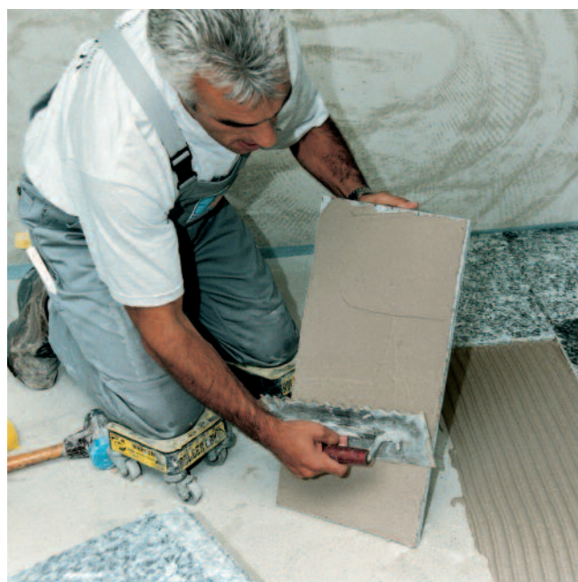
Zum hohlraumfreien Verlegen wird grundsätzlich eine Mörtelschicht auf die Plattenrückseite aufgetragen.
