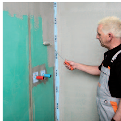
Nachdem die Details ausgebildet wurden, erfolgt die Flächenabdichtung mit dem jeweiligen Abdichtungsmaterial.
