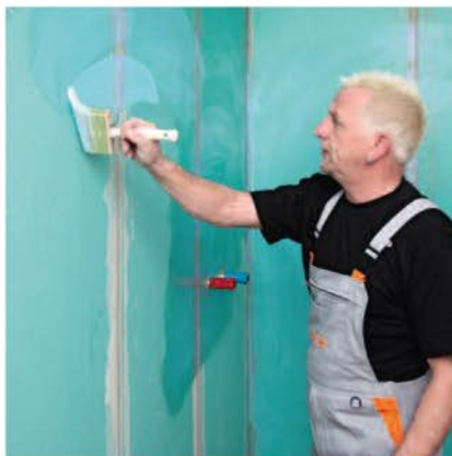
1. Grundierung PCI Gisogrund flächendeckend auftragen.
