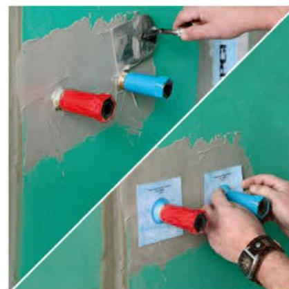
2c. Zum Abdichten der Wasserzuleitungen wird zunächst ausreichend viel Abdichtungsmaterial PCI Lastogum vorgelegt.
