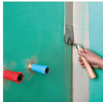
2a. Vor dem Ausführen der Wand-Bodenanschlüsse ausreichend viel Abdichtungsmaterial PCI Lastogum auftragen.
