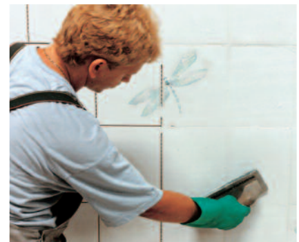
Mit PCI FT Fugengrau und PCI FT Fugenweiß können Fugen von 2 bis 8 mm Fugenbreite rissefrei verfugt werden.
