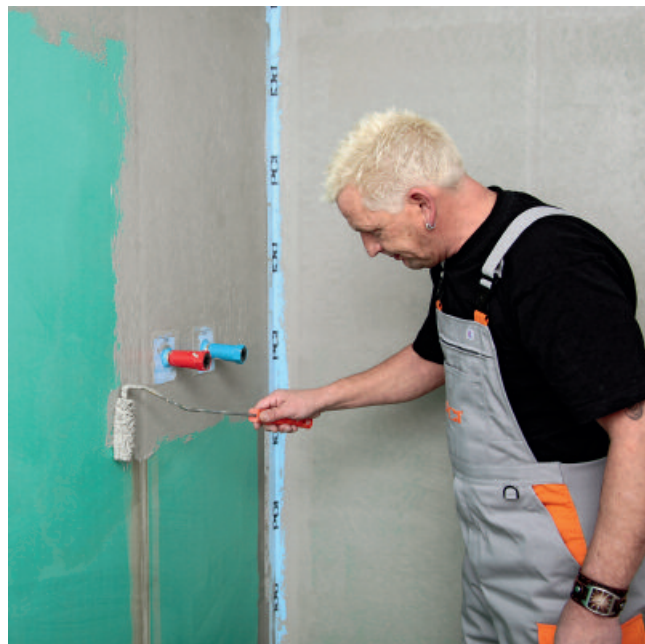
4. Erste Schutzschicht mit PCI Lastogum (grau) unverdünnt satt und oberflächendicht auf den Untergrundaufträgen.
