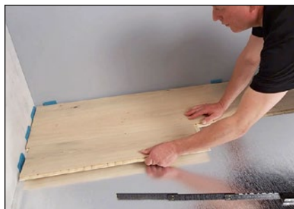
Die nächste Reihe wieder von links beginnen. Klicken Sie die Dielen einfach längsseitig zusammen. Eine Verleimung der Dielen ist nicht erforderlich.
