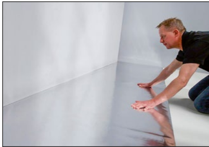
Verlegeunterlage auf vorbereitetem Untergrund auslegen.
