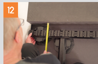
Erste Systemschiene positionieren
