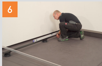
Konterlattung ausrichten
