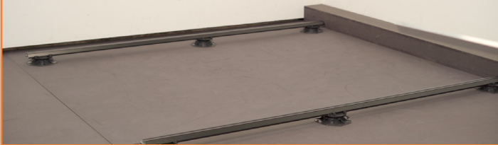
Konterlattung positionieren
