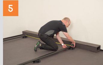
Konterlattung positionieren
