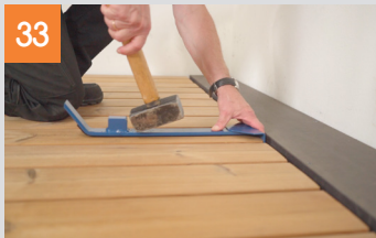
Diele herausnehmen und wieder einsetzen
