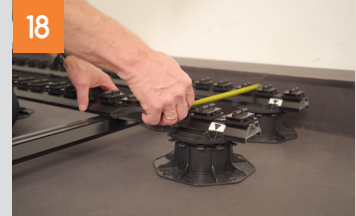
Systemschienen verlegen
