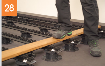
Erste und zweite Diele montieren
