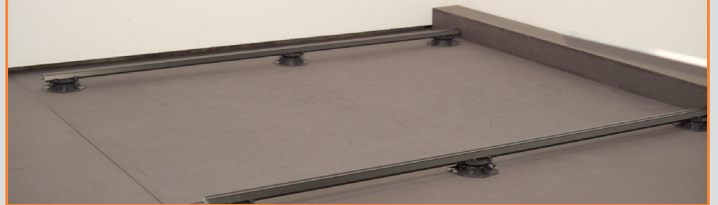
Konterlattung positionieren
