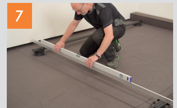
Konterlattung ausrichten
