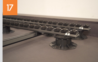
Systemschienen verlegen
