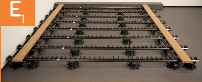
Erste und zweite Diele montieren
