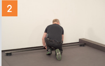
Konterlattung positionieren
