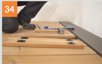
Diele herausnehmen und wieder einsetzen
