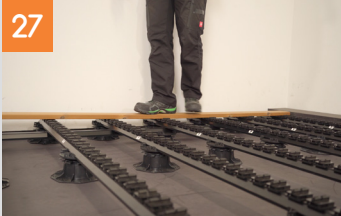
Erste und zweite Diele montieren
