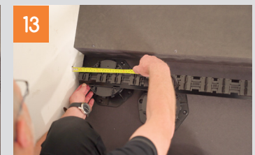
Erste Systemschiene positionieren
