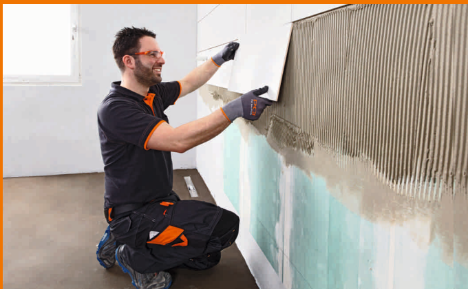
Entspannt und kraftsparend verlegen.
