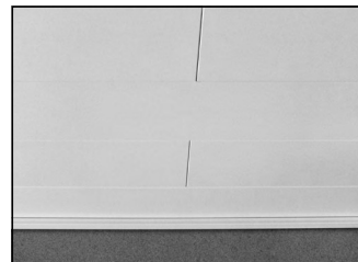
Deckenabschlussleisten aufstecken – fertig
