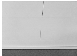
Deckenabschlussleisten aufstecken – fertig
