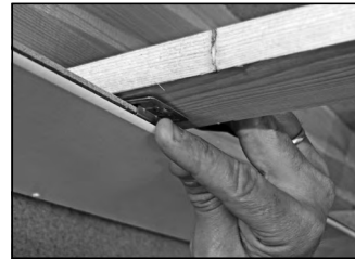
Befestigungskralle setzen
