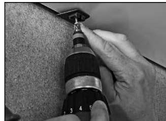
Leistendclip montieren
