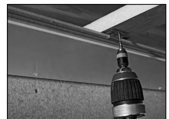
Befestigungskralle anschrauben
