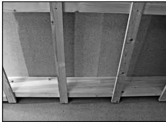
Unterkonstruktion
