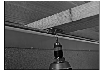
Befestigungskralle anschrauben
