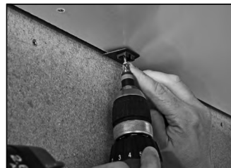
Leistendclip montieren
