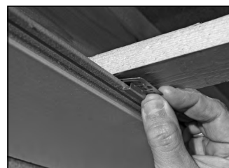
Befestigungskralle setzen
