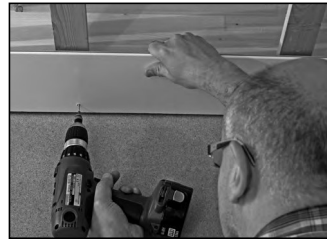
Erstes Steck-Paneel befestigen
