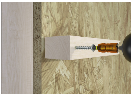
Befestigung einer Installationsebene
