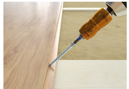
Fixierung von Dielenbelag
