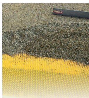
Pose dans un empierrement de graviers / gravillons
