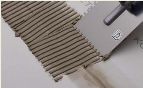
**6** Das AQUAPANEL® Fugenband auflegen, mit Glättkelle eindrücken und glätten. Anschließend trocknen lassen.
